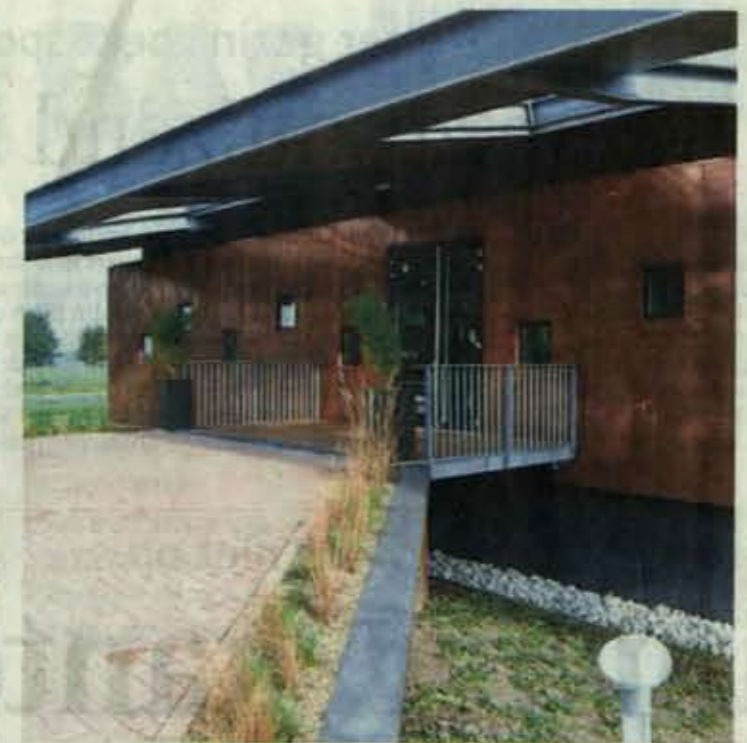
De entree van het duurzame pand.
